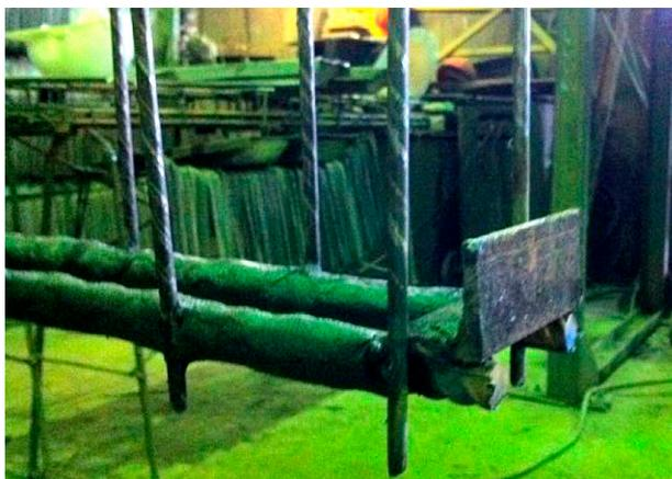
Рис. 7.3. Общий вид анкерного уголка на опоре балки
